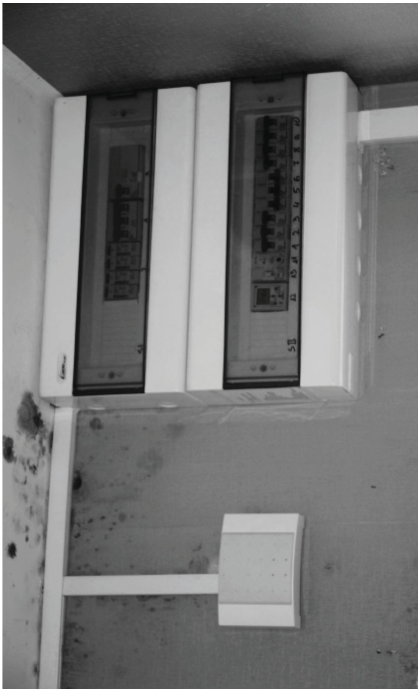
Na skutek długotrwałego użytkowania pomieszczeń do tego nieprzystosowanych pojawia się grzyb i pleśń.
